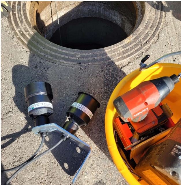
Kuva 8 anturipari (pinnankorkeus ja nopeus) valmiina asennettavaksi kaivoon
