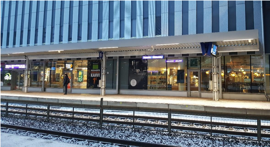
Tikkurilan asemalla palvelut avautuvat suoraan laiturille.
