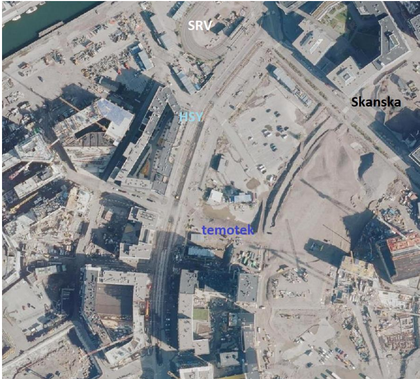
Kuva 1. Mittalaitteen sijainti ja työmaat Jätkäsaaren mittauspisteen lähiympäristössä. Ortokuva 2019.
