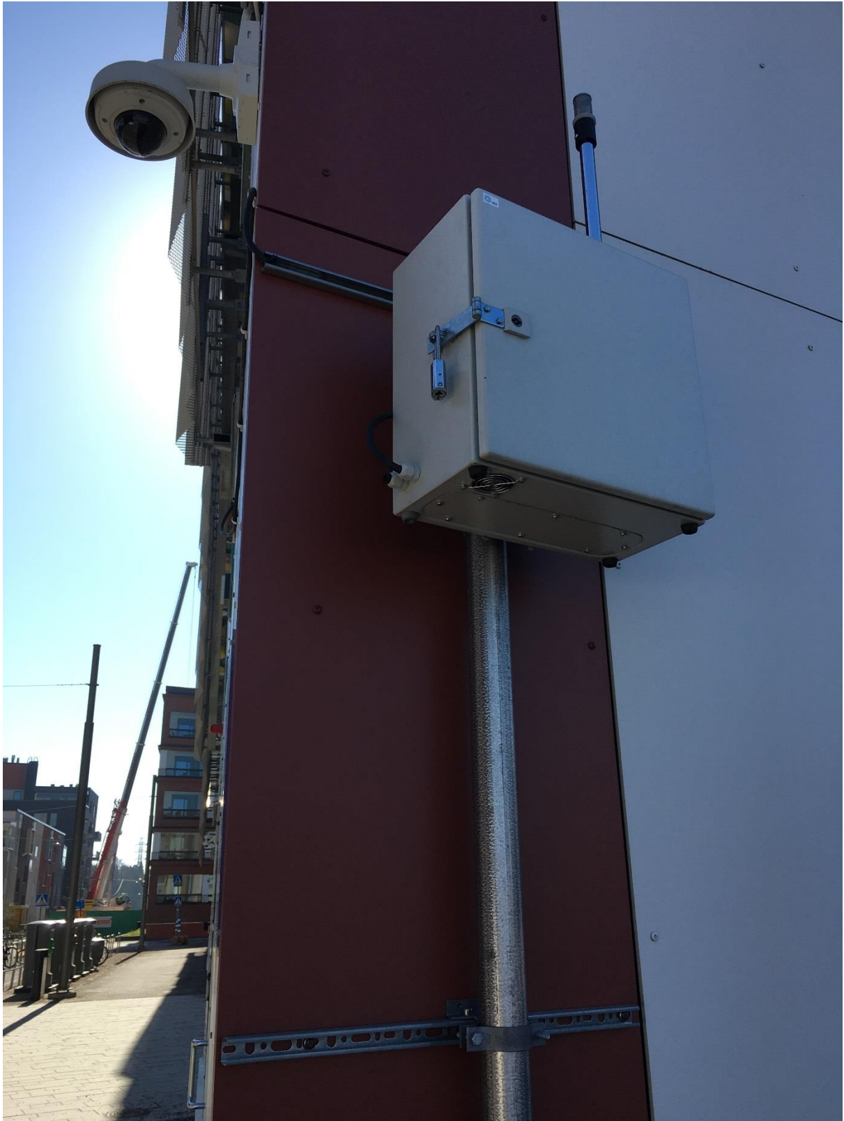
Kuva 2. Mittalaite lännestä kuvattuna. Kuvassa näkyy jalkakäytävä sekä työmaarakentamista.
