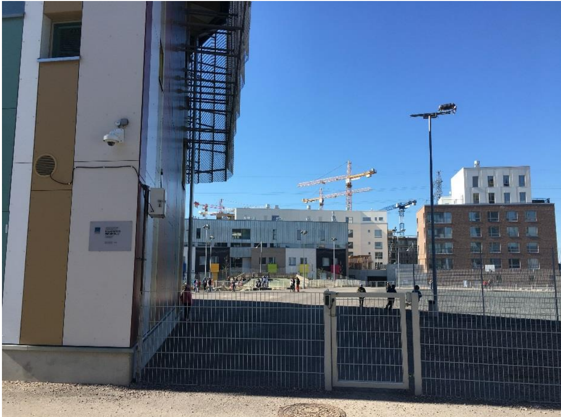
Kuva 3. Mittalaite ja koulun piha pohjoisesta kuvattuna. Kuvassa näkyy jalkakäytävä sekä Polariksenkatu 1. Ete- lässä näkyy Skanskan työmaarakentamista.
