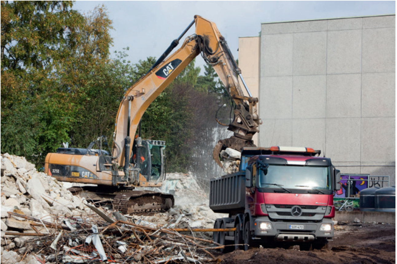
Kuva 24. Asuinkerrostalon purkutyömaa Vantaan Mikkolassa (lähde: VAV Asunnot/ Henrik Kettunen)
