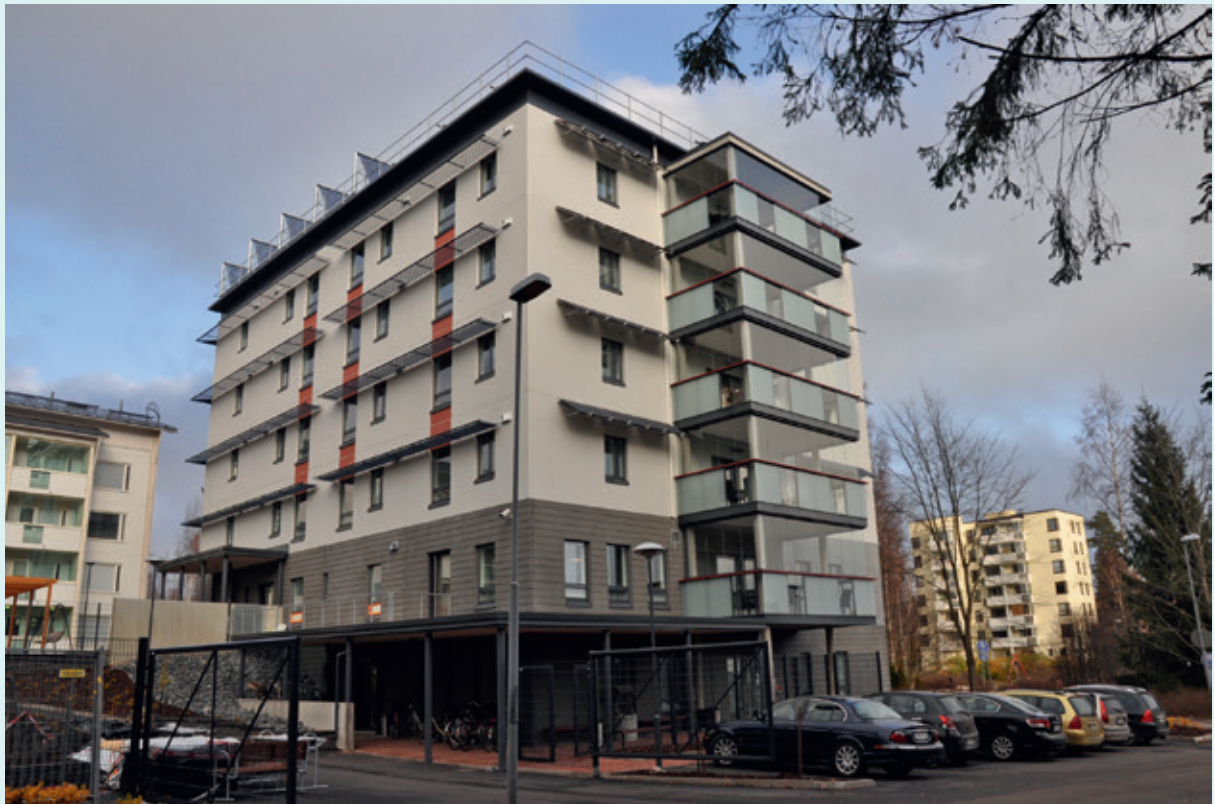
Kuva 31. Nollaenergiatalo Jampankaari 4 E Järvenpäässä (lähde: Järvenpään Mestariasunnot)
