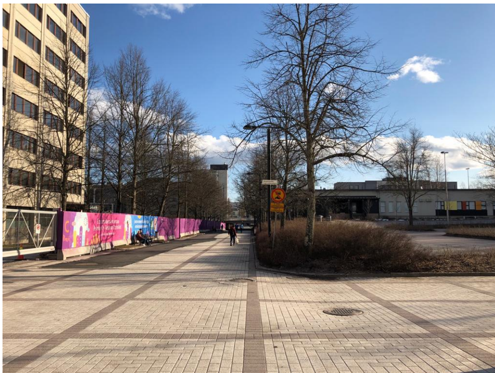
Kuva 6. Kuvassa keskellä Myyrmäen raitti, vasemmalla puolella purkutyömaa ja oikealla päiväkot, minkä vasemmalla seinustalla mittauspiste sijaitsi.
